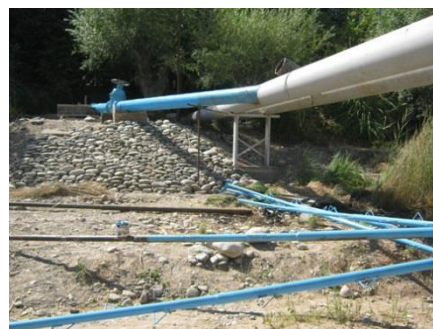
Рис. 7. МикроГЭС мощностью 5 кВт в селе Кыпчак-Талаа (Ноокенский район).
