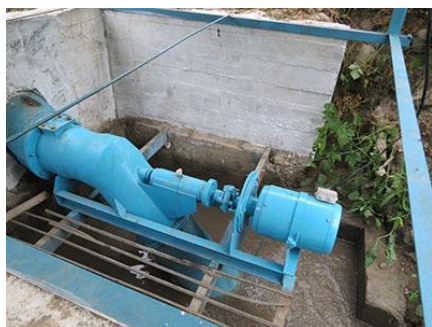
Рис. 4. МикроГЭС мощностью 85 кВт в селе Кербен (Аксы́йский район).
