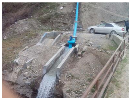
Рис. 5. МикроГЭС мощностью 5 кВт в селе Кашкалдак (Ноокатский район).
