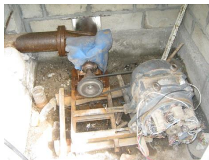
Рис. 2. МикроГЭС мощностью 5 кВт в ущелье Чычкан (кафе «Огонек»).
