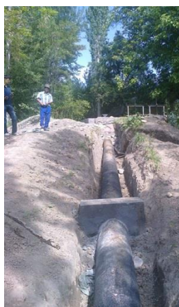
Рис. 7. МикроГЭС мощностью 5 кВт в селе Кыпчак-Талаа (Ноокенский район).
