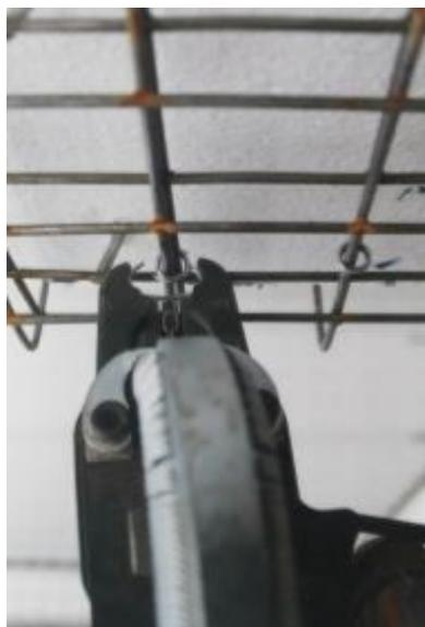
Рис. 4.22. Крепление соединительной сетки с помощью выгибающей пушки
