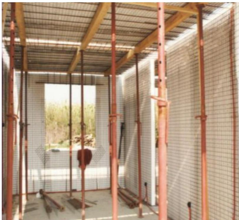
Рис. 4.31. Оптимальное расположение поддерживающих конструкций
