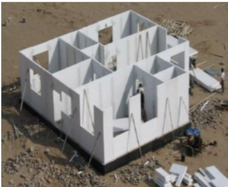
Рис. 4.24. Стена, раскрепленная связями
