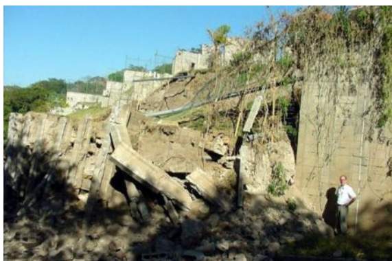
Рис. 1.4. Результаты последствий землетрясений на подпорные сооружения: а) - смещение подпорной стены, произошедшее в результате землетрясения 2004 г. в местности Ниигата (Япония); б) - обрушение секции стены на Riverside Drive and Henry Hudson Parks 12 мая 2005 г. (Сидней, Австралия); в) - железобетонная подпорная стена после Ханшинского землетрясения 1995 г; г) - обрушение подпорной стены в результате смещения увлажнившейся массы сильно подрезанного склона; д) - железобетонная подпорная стена после Ханшинского землетрясения 1995 г; е) - массивная подпорная стена после Ханшинского землетрясения 1995 г.
