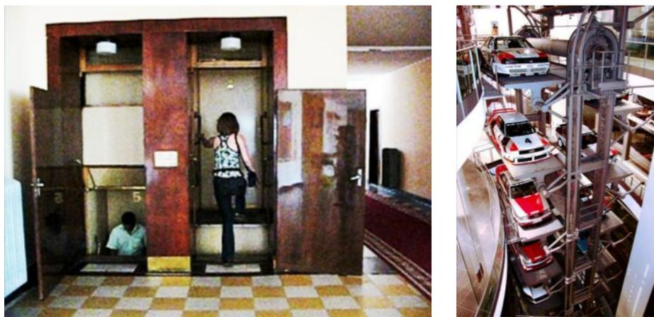
Рис. 6. Вид пассажирского (слева) и грузового лифта-патерностера
