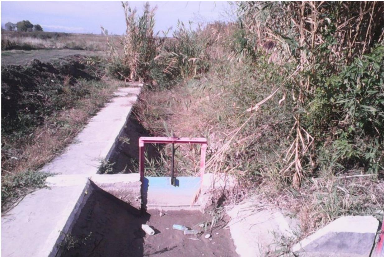
Рис. 1. Водомерное сооружение типа «фиксированное русло» (оно расположено за плоским щитом) на канале КРВХ-2 Р-24 системы канала ЗБЧК.
