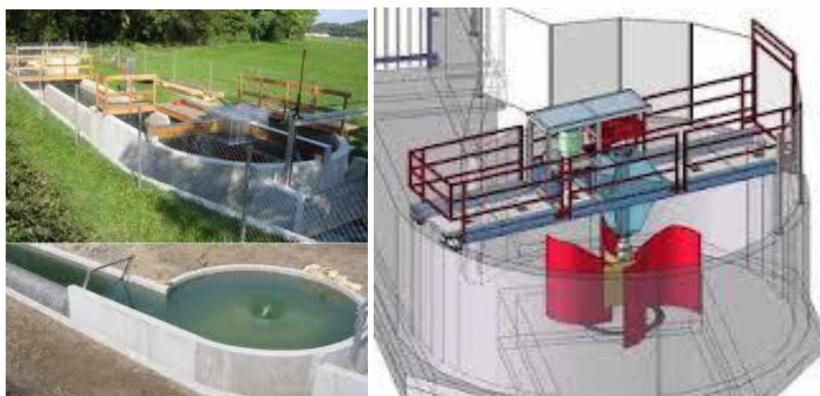
Рис.1 Водоворотная микро ГЭС Франца Цотлётерера
