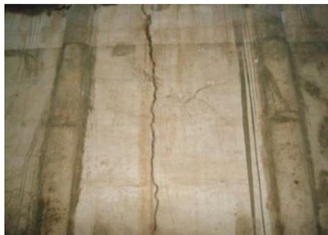
Рис. 4. Фото видов трещин на стенке в РЧВ
