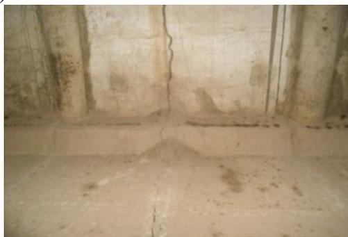
Рис.3. Вид сквозной трещины, переходящей от стены на днище
